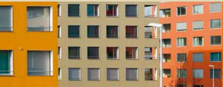
Verputzte Aussenwärmedämmung / Isolation thermique extérieure crépie
